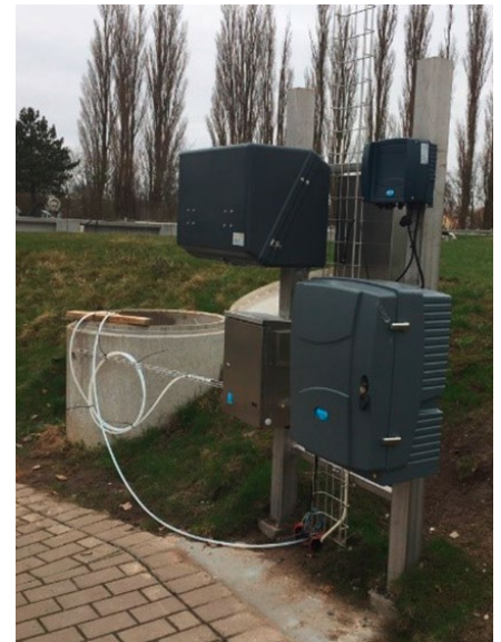
Figura 2: analizador de amonio Hach Amtax sc, sensor de nitratos Nitratax sc y módulo de sondas del controlador SC1000.
